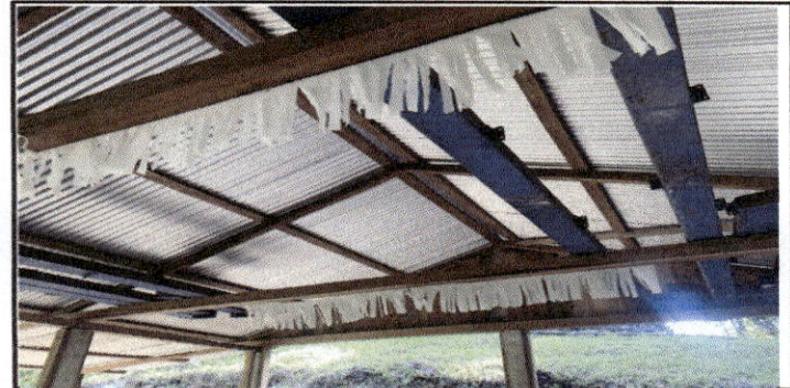
Foto 10: Interior de estructura del módulo 2.
