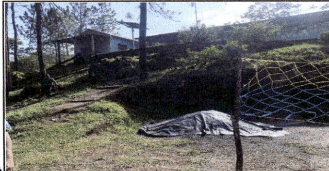
Foto 9: Patio principal sin piso de concreto.
